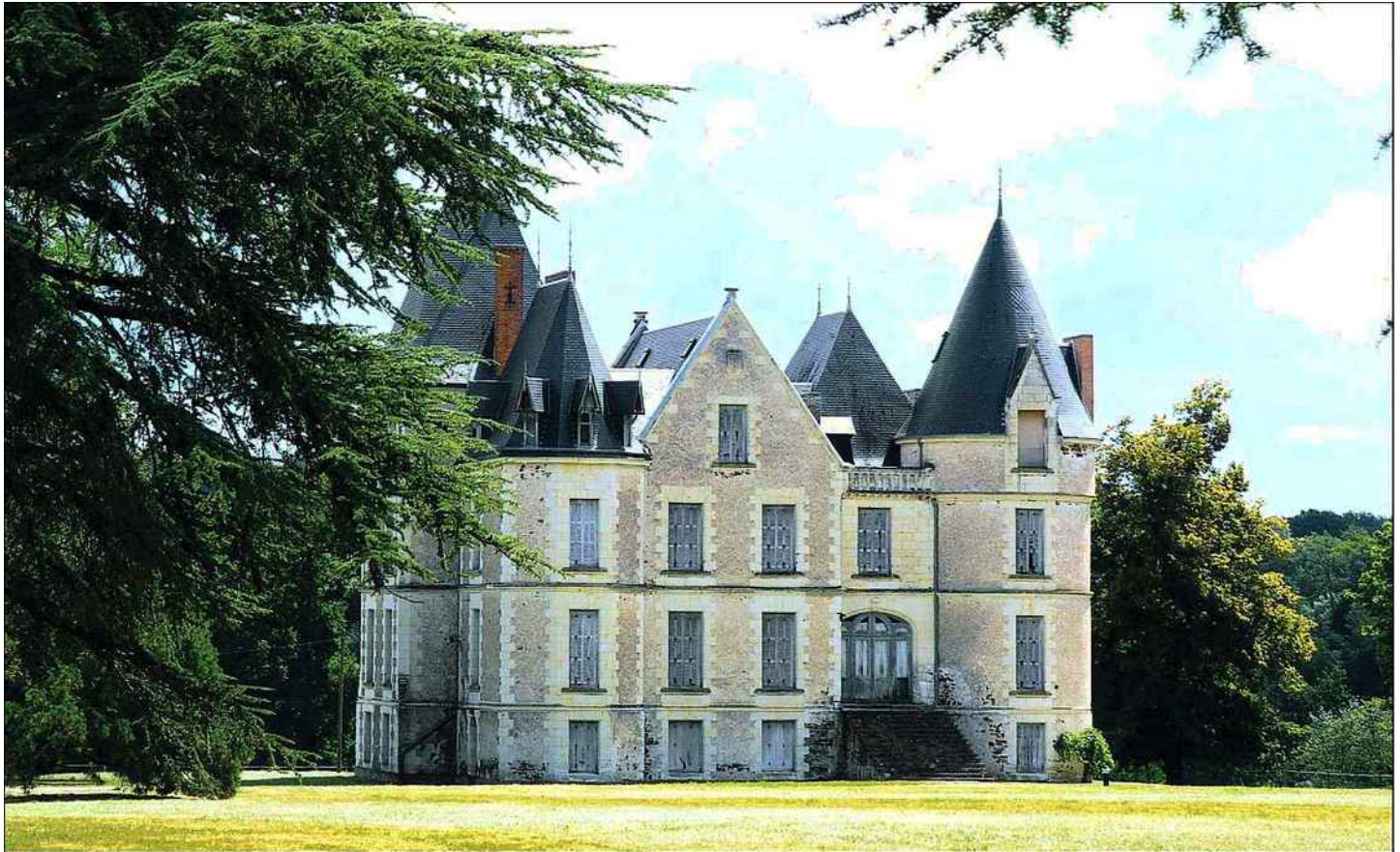
En 1986, le château de Boisbuket, son domaine et ses dépendances ont plu instantanément à Alexander von Vegesack, devenu propriétaire. PHOTOS DR
